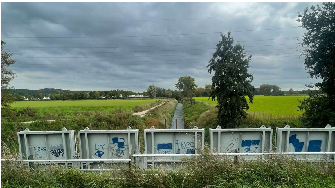
Figuur 3-2 De situatie direct bovenstrooms van de sifon
