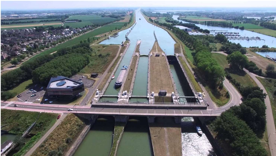
Figuur 6-2 Beeld sluis Maasbracht
