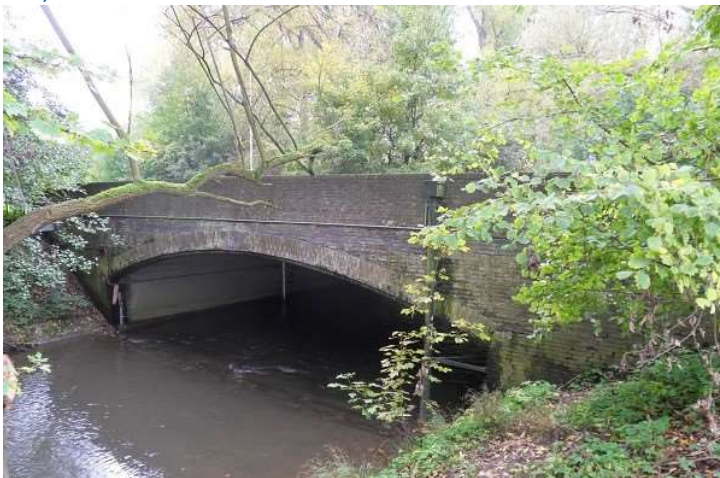
Figuur 5-1 Brug bij Maastrichterlaan (foto Waterschap Limburg)
