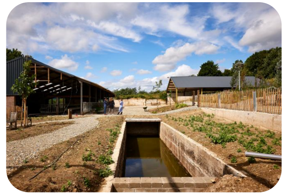
Natuurboerderij De Hofkamer – Project: Ondergrondse wateropvang. Oude mestputten als waterbuffers.
