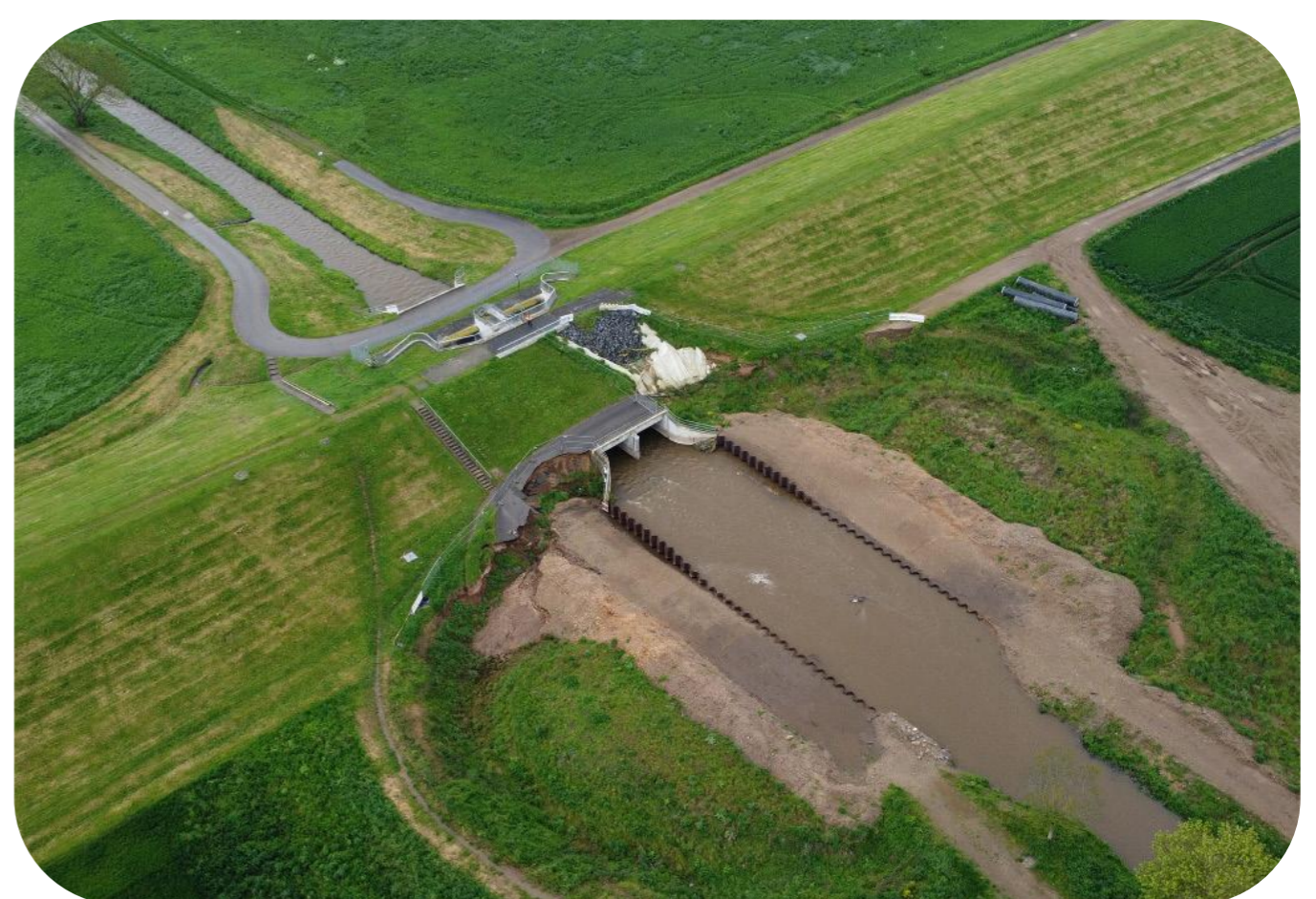
Voorbeeld in Duitsland hoe een dwarsdam eruit kan zien.
