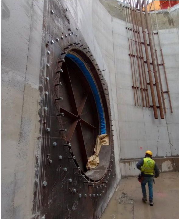
Afbeelding 11.21 Groutzak (blauw) die opgevuld wordt tegen de tunnelbuis om deze waterdicht te maken
