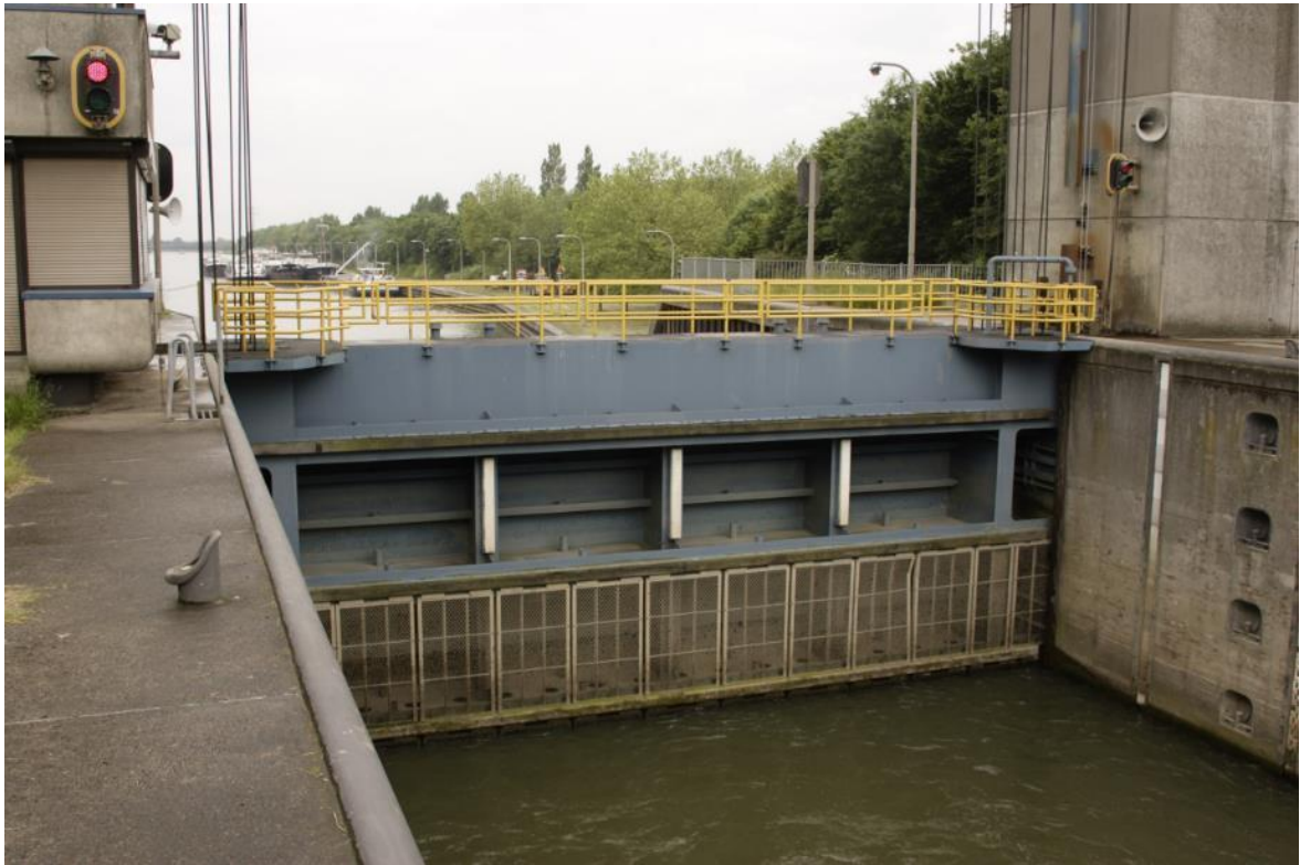
Afbeelding 4.6 Beweegbare schuif / hefdeur (Sluis 16, Weert)
