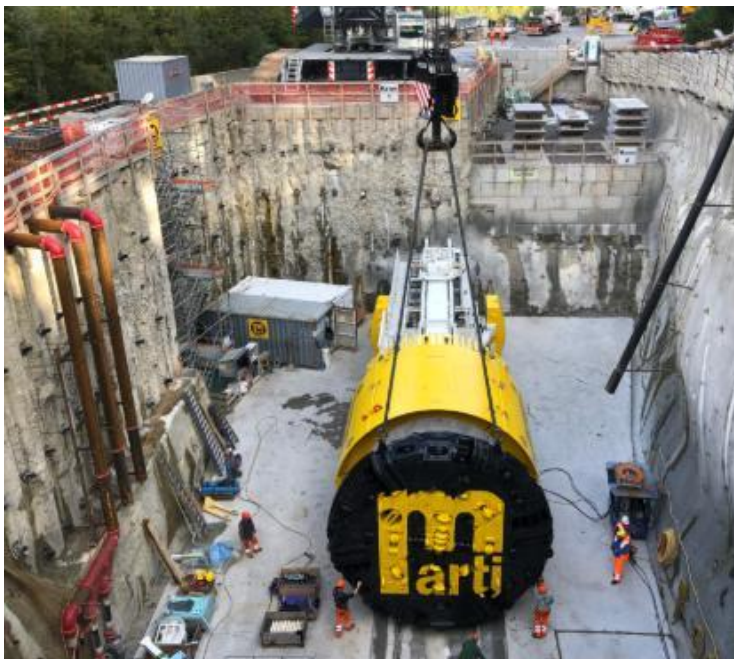
Afbeelding 11.22 Boorkop GFT boring (bron: Sarneraa mit Hochwasserentlastungsstollen Ost – Hochwasserschutz Obwalden)
