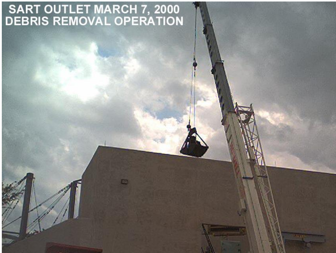
Afbeelding 10.3 Kraan met grijper bij San Antonio Tunnel (bron: San Antonio River Authority)
