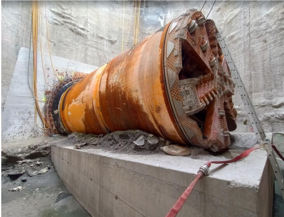
Afbeelding 11.28 Doorbraak GFT-boring
