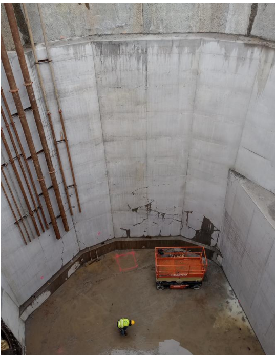
Afbeelding 11.19 Afwerkwand voor diepwand
