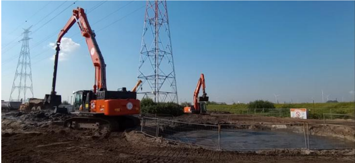
Afbeelding 11.14 Ontgraving schacht
