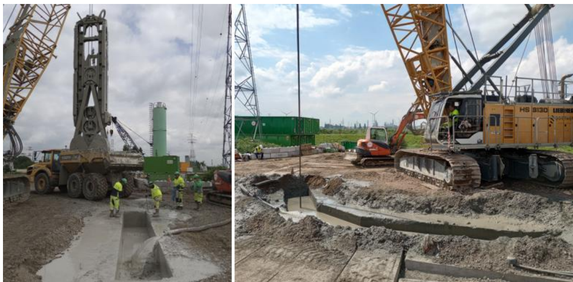
Afbeelding 11.11 Graven diepwand, één diepwandpaneel bestaat uit drie graafgangen
