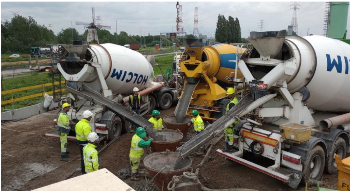
Afbeelding 11.13 voor betonning van een diepwand paneel, per paneel (20m diep) zijn een tiental mixers benodigd.
