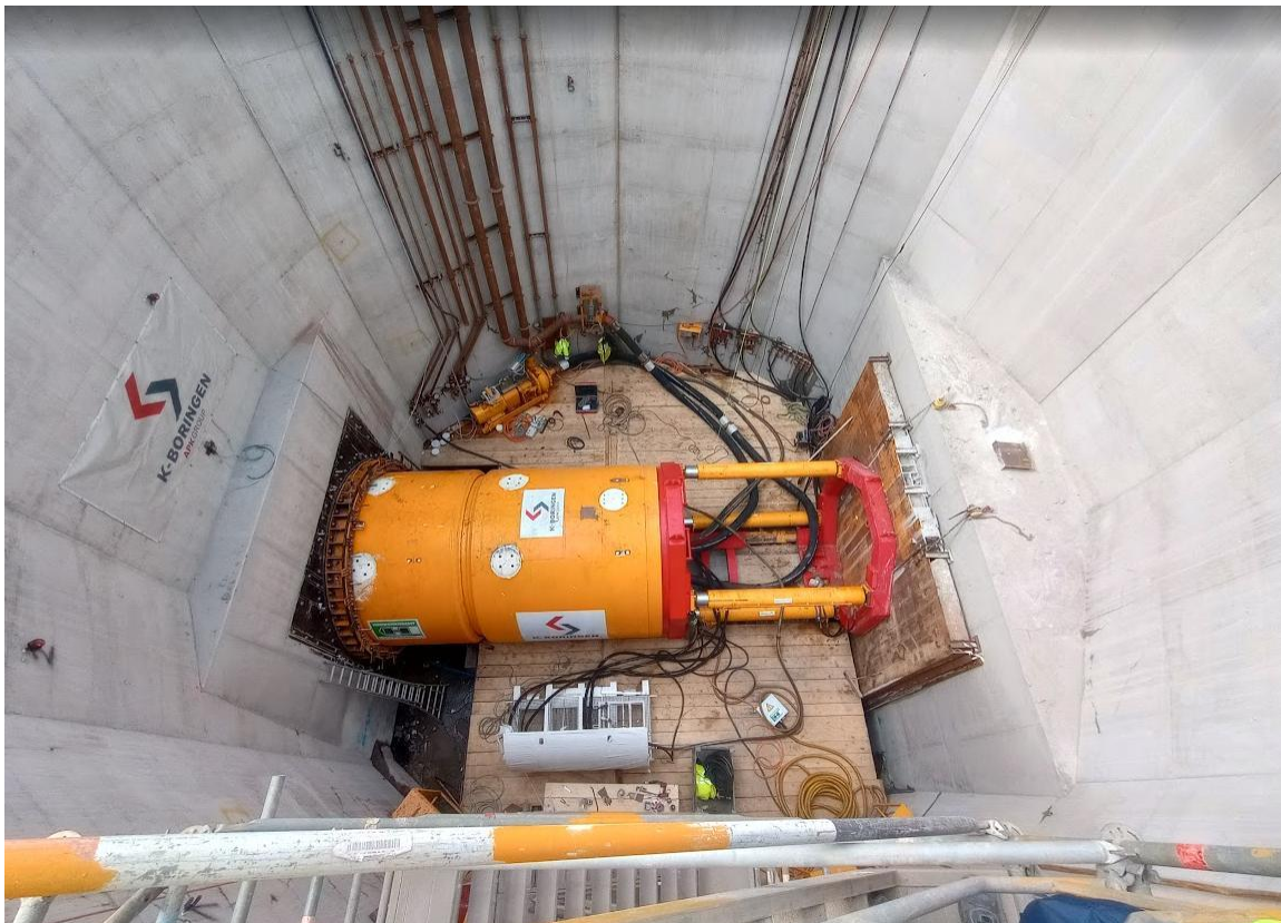
Afbeelding 11.20 Boormachine in uitlaatschacht met hydraulische pers, rechts het afzet of persblok, links het vertrekblok
