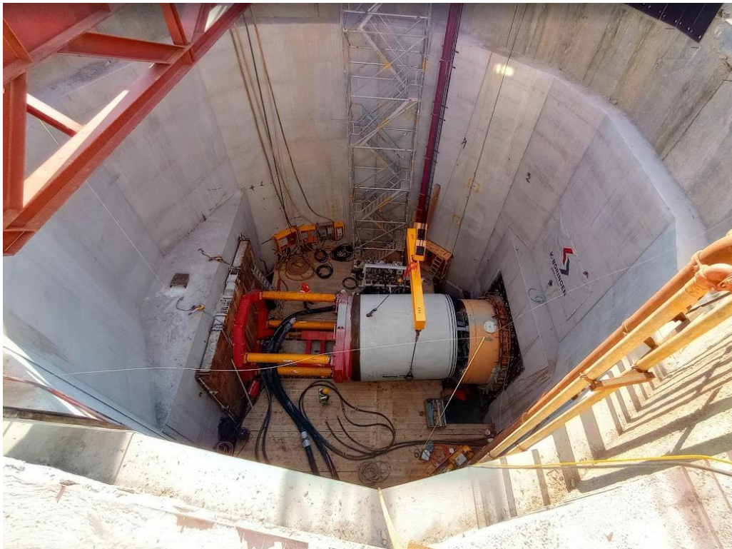
Afbeelding 11.24 tunnel element wordt geplaatst in hydraulische pers
