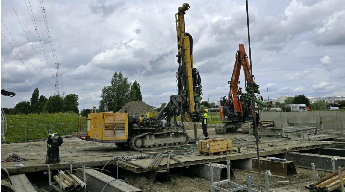
Afbeelding 11.15 Plaatsing trekpalen Ecluse II
