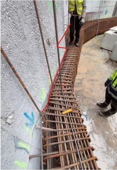
Afbeelding 11.18 diepwapaneel uit tolerantie (sprong van 40cm) op project Ecluse II
