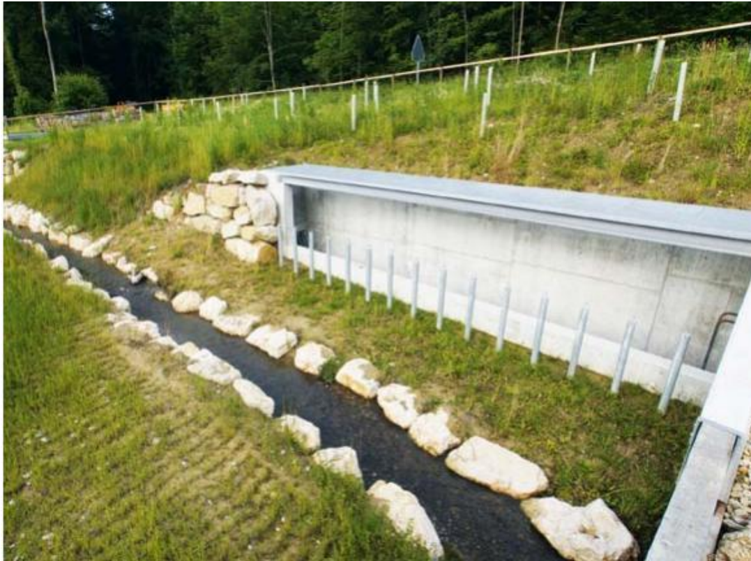
Afbeelding 4.11 Langwerpige uitlaatconstructie (Lyss, Zwitserland)
