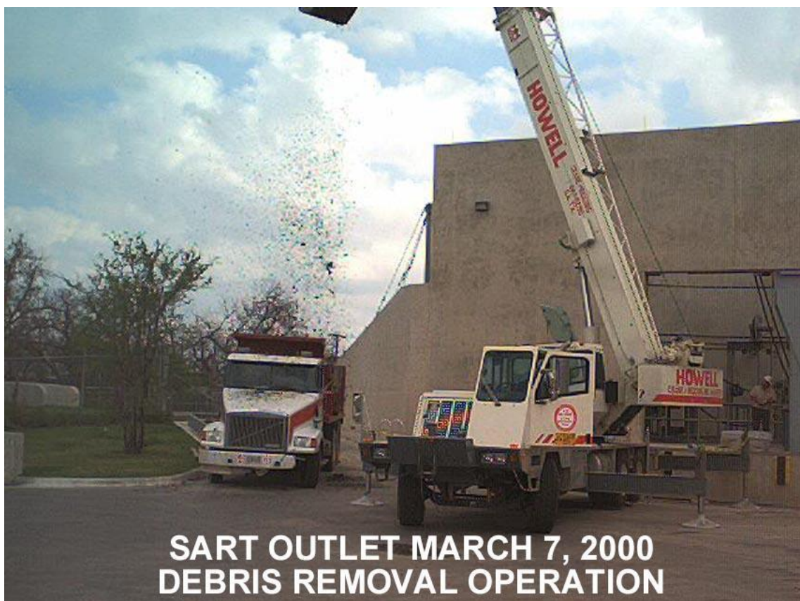
Afbeelding 10.6 Kraan met grijper en kiepwagen bij San Antonio Tunnel (bron: San Antonio River Authority)
