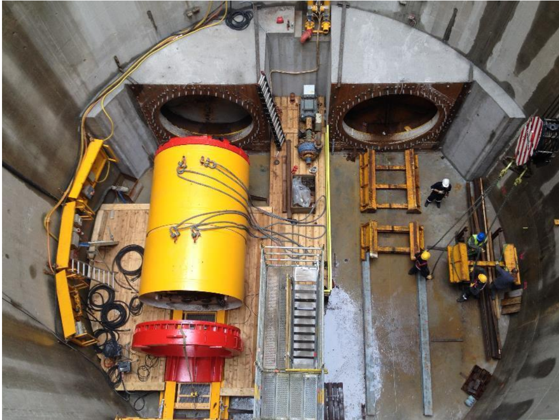
Afbeelding 4.13 Uitvoering dubbele GFT-boring (bron: K-Boringen)
