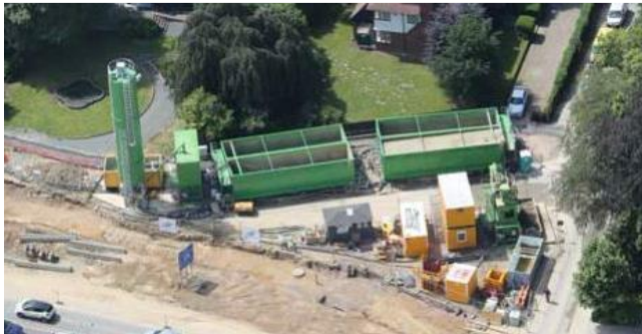
Afbeelding 11.7 Typische terreininrichting voor diepwand uitvoering
