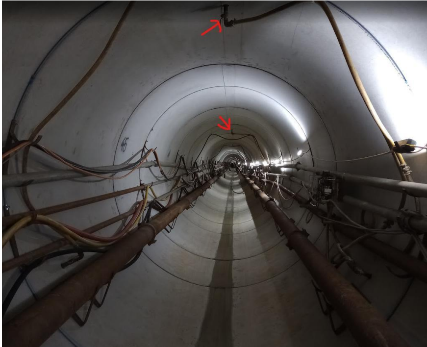
Afbeelding 11.25 Inbrengen bentonietmengsel tussen tunnel element en boorgang
