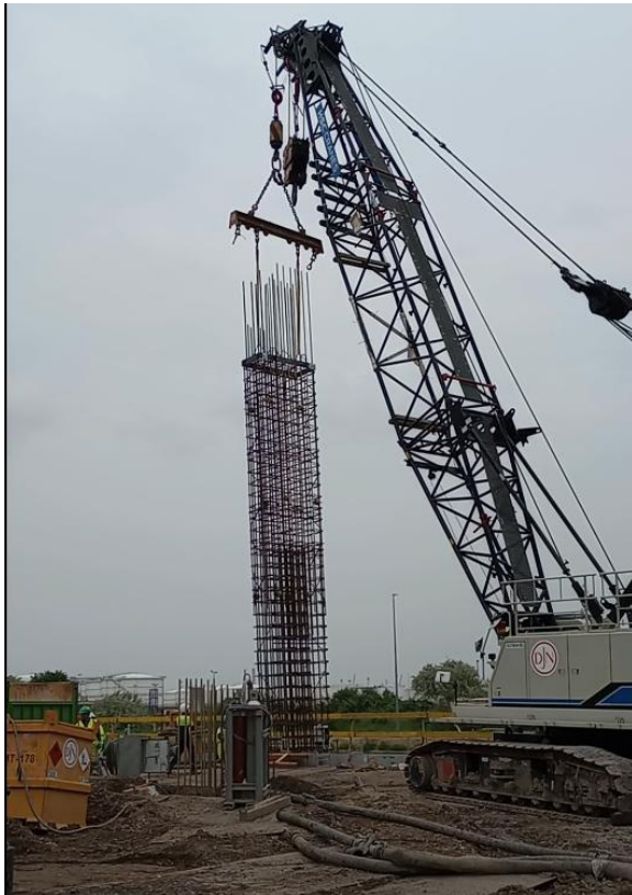
Afbeelding 11.12 Plaatsen wapeningskooi in diepwandsleuf
