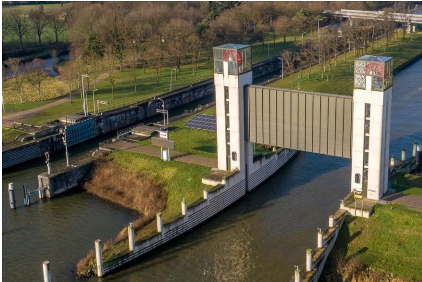
Afbeelding 5.1 Westkolk Sluis Weurt (Stalen hefdeur 14 m, met kabeltrommels)
