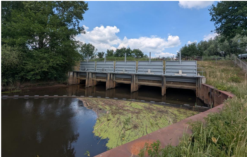
Afbeelding 5.3 Dommelduiker Wilhelminakanaal (stalen deuren 5 m breed)
